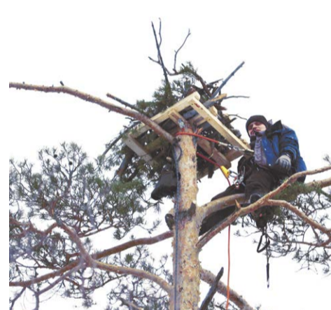
Строительство гнезд с использованием методов арбористики
